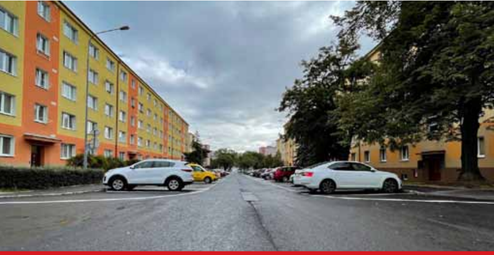
V ulici Československé mládeže přibýlo nové vodorovné značení a z původního počtu 44 parkovacích míst podařilo rozšířit parkovací kapacitu na 66 míst.
