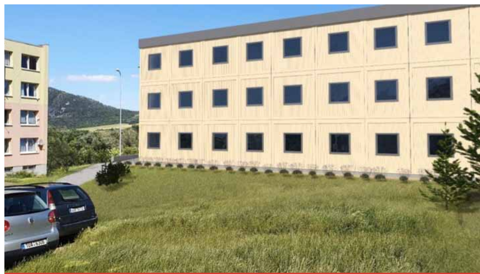
Podle nových propočtů v důsledku skokového zdražení by jeden nový byt v modulu vyšel na dva a čtvrt milionu korun. Proto město tento projekt v Chanově zatím realizovat nebude.
