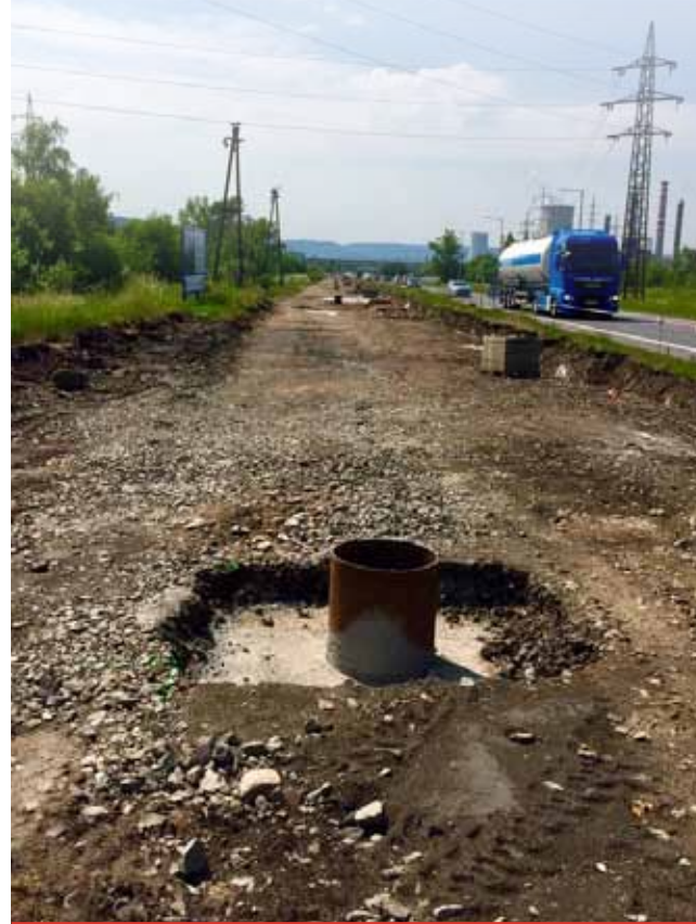
Tramvajová trať vedle hlavní komunikace je kompletně demontovaná. Pripomína staveniště podobné při stavbě dálničních tepen.
