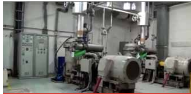
Důležitá byla výměna zastaralého kompresoru.
