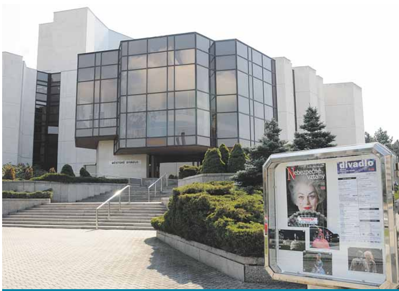
Město se postupně pustilo do rekonstrukce vnitřků městského divadla. I letos v létě tu bude panovat čilý stavební ruch.
