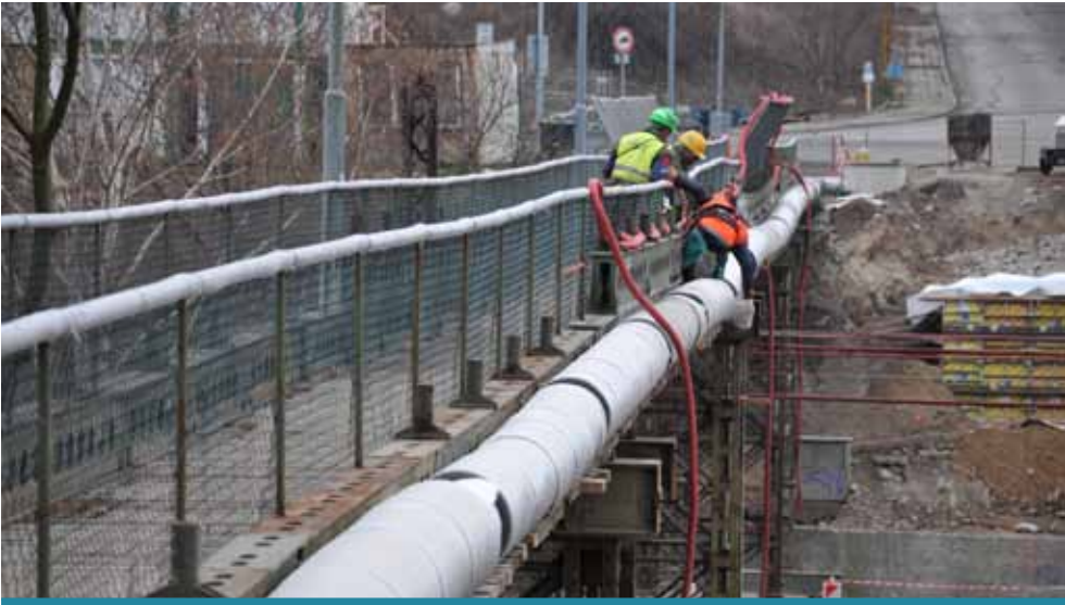
Po novém mostě do Rudolic se budeme moci projet příští rok v říjnu.
