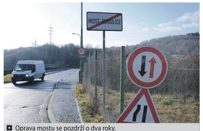
■ Oprava mostu se pozdrží o dva roky.
