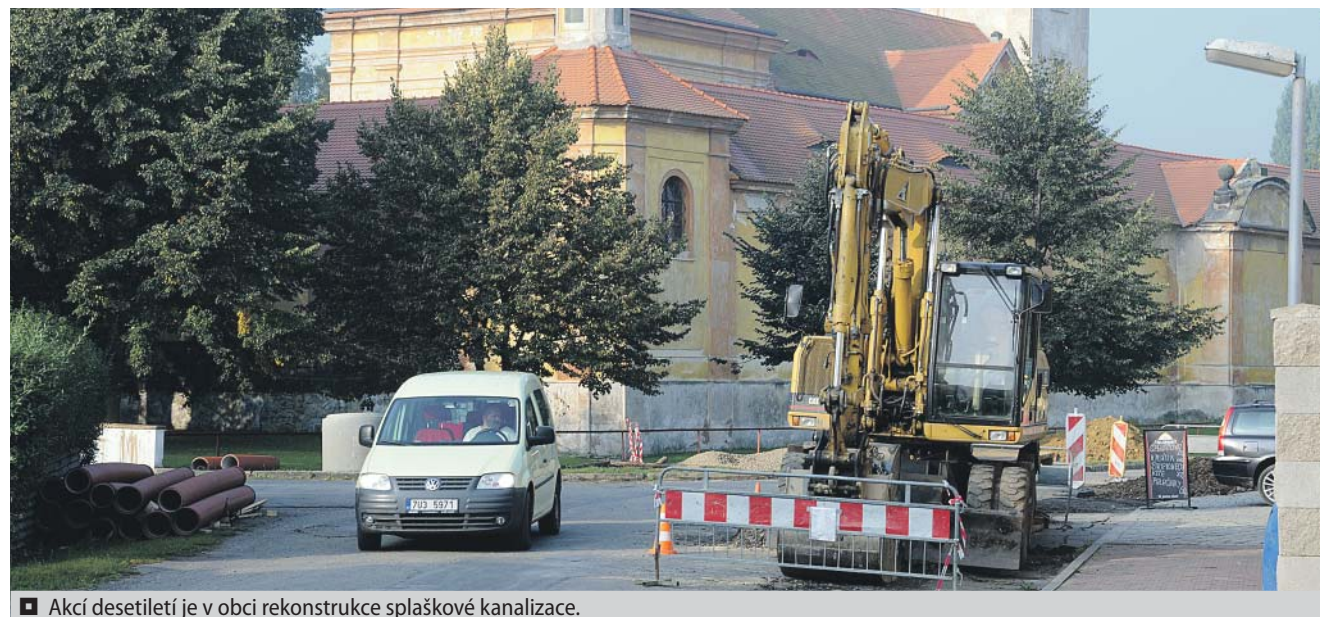
☐ Akci desetiletí je v obci rekonstrukce splaškové kanalizace.
