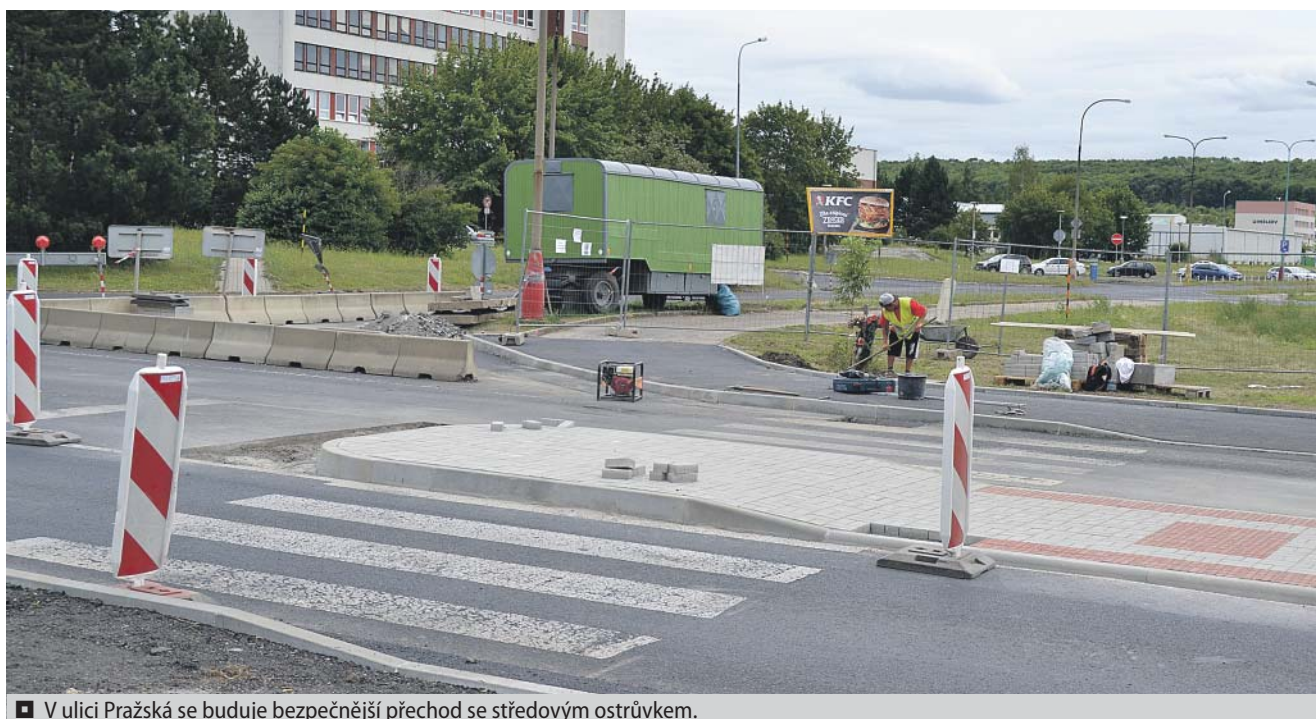
■ V ulici Pražská se buduje bezpečnější přechod se středovým ostrůvkem.
