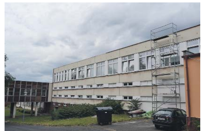
Pracuje se i na opravě střechy bývalé 16. ZŠ v Albrechtické ulici.
